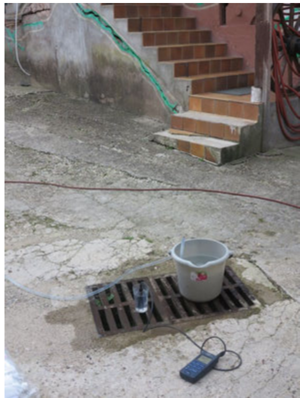
Photographie 36 – Rejet des eaux pompées dans le réseau pluvial (propriété Matjeka)
