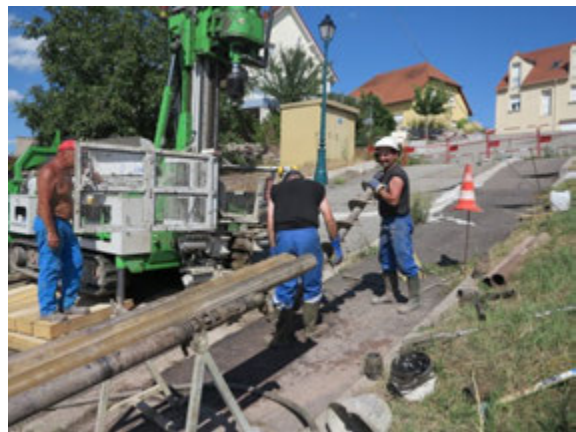
Photographie 13 – Forage de l'avant-trou
