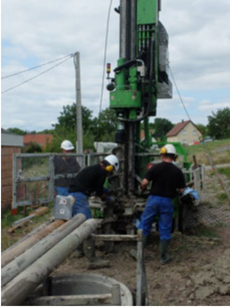
Photographie 6 – Tarière hélicoïdale pour forer l'avant-trou
