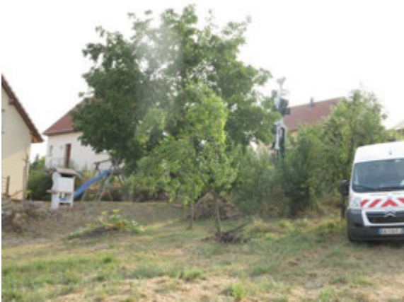
Photographie 22 – Vue du chantier
