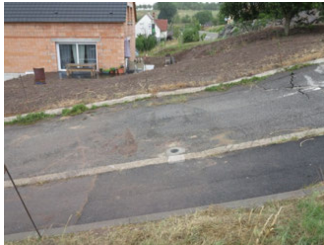
Photographie 16 – Vue du piézomètre SC5 terminé
