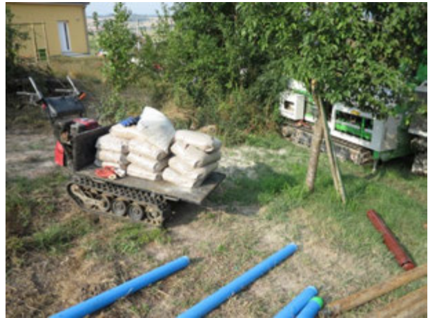
Photographie 23 – Vue du chantier, forage en cours d'équipement
