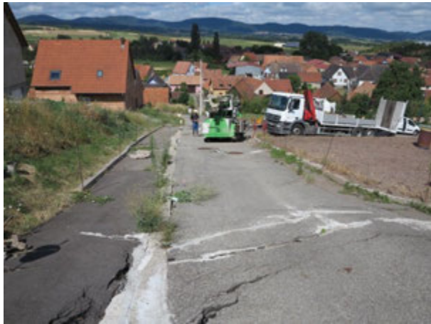
Photographie 12 – Déplacement de la foreuse
