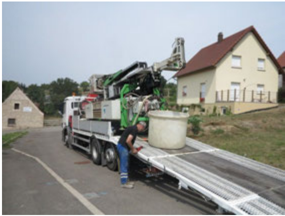
Photographie 20 – Déplacement de la foreuse
