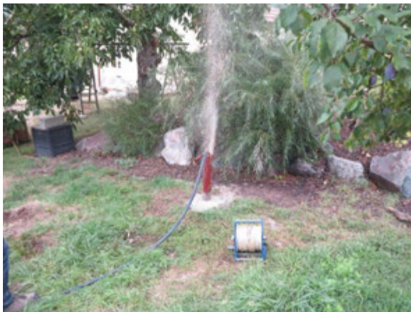
Photographie 31 – Air-lift sur SC6-2
