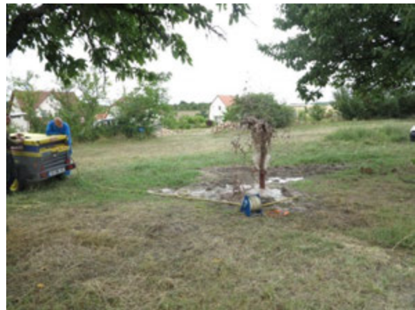
Photographie 32 – Air-lift sur SC7
