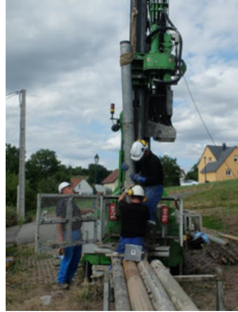
Photographie 7 – Descente des tubes d'avant-trou
