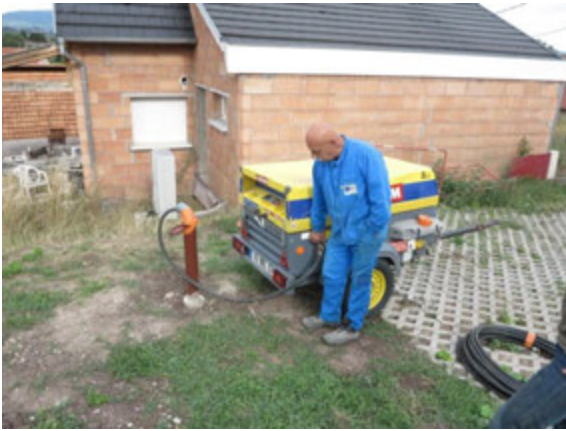
Photographie 29 – Mise en place du dispositif sur SC4
