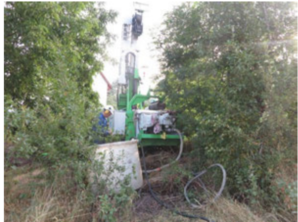
Photographie 21 – Vue du chantier
