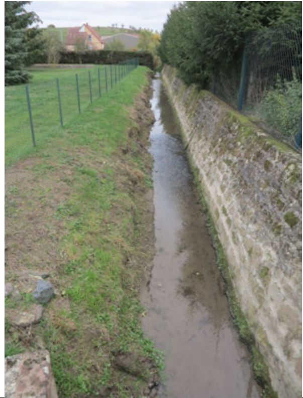
Photographie 44 – Ruisseau Dachsgraben (vue vers l'amont)
