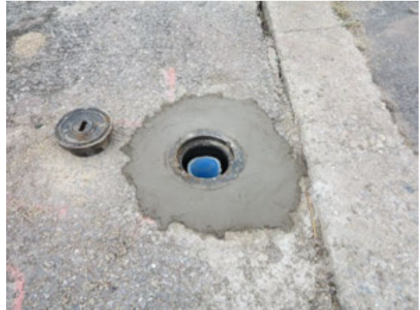
Photographie 15 – Vue du piézomètre SC5 terminé
