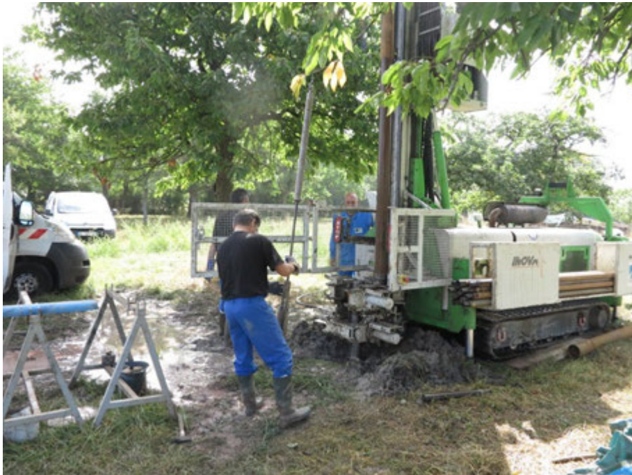
Photographie 19 – Vue du chantier
