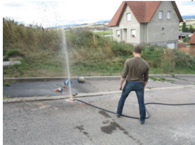
Photographie 30 – Air-lift sur SC5
