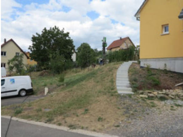
Photographie 17 – Vue du chantier
