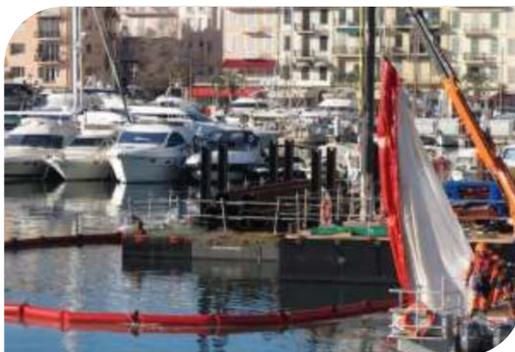
*Mise en place barrage filtrant MES pour travaux maritimes BTM- port de CANNES – image DIFOPE*
