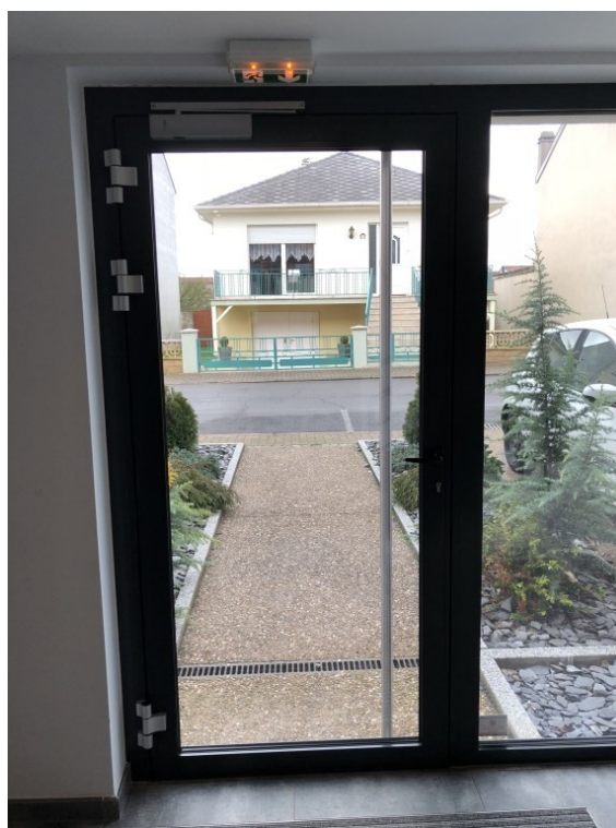
Porte d'entrée d'immeuble vitrée sans contraste visuel
