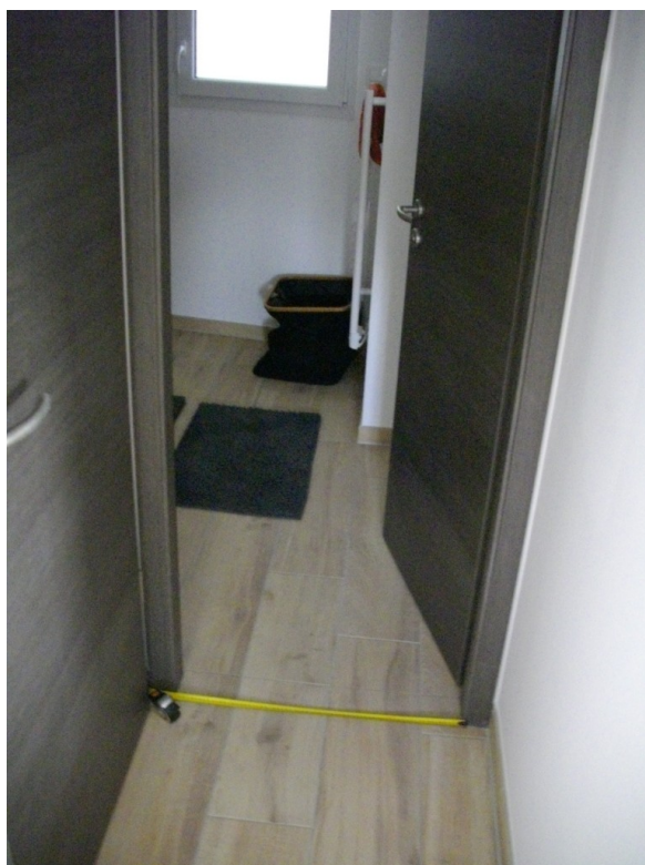
Porte intérieure de SdB de largeur 70 cm
