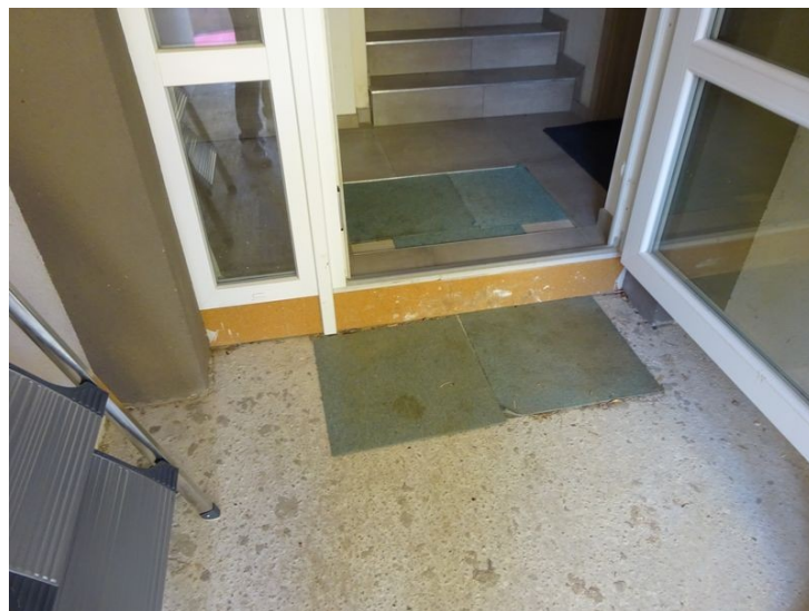
Entrée principale d'un bâtiment avec ressaut important
