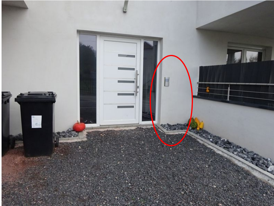
Entrée principale d'un bâtiment avec impossibilité d'accéder au portier en fauteuil roulant
