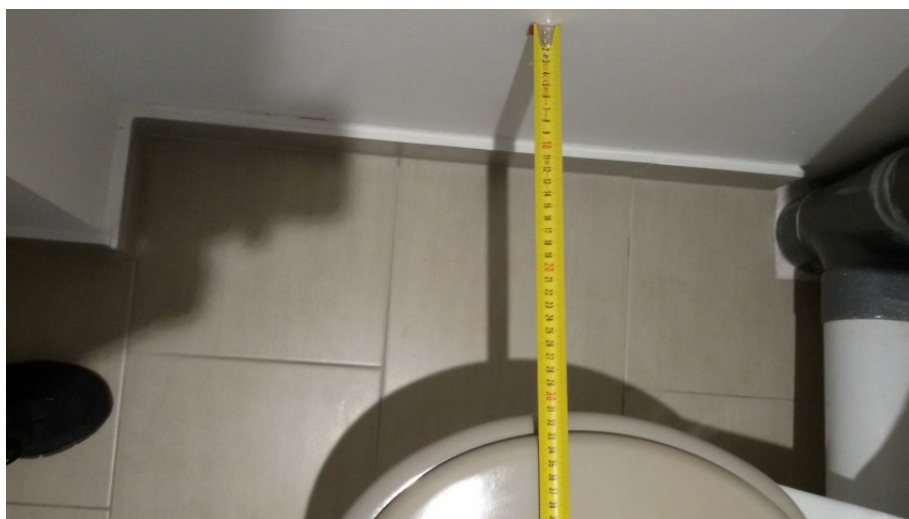
Absence d'espace de manœuvre latéralement à la cuvette
