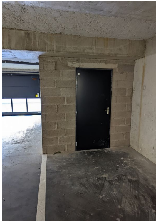
Issue sans repérage dans un parc de stationnement couvert
