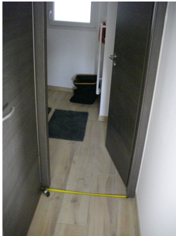
Porte intérieure de SdB de largeur 70 cm
