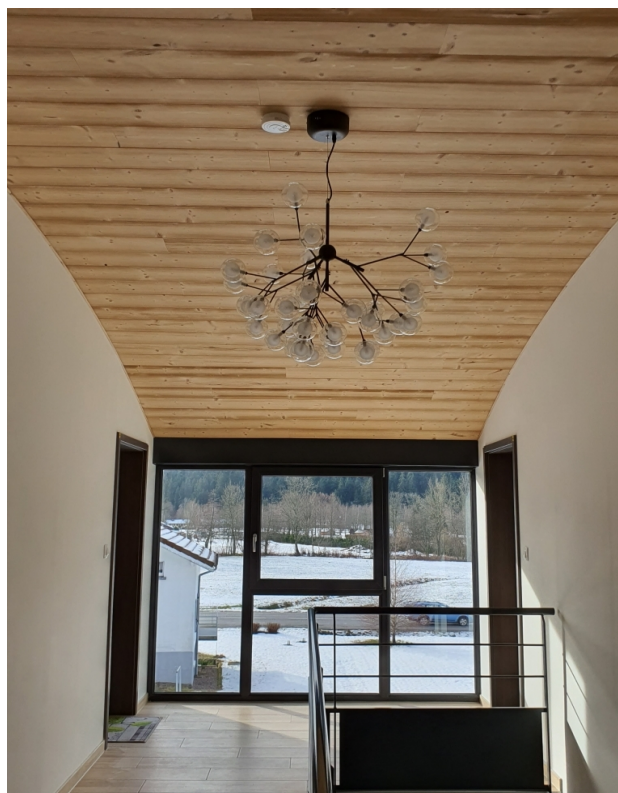
Palier haut de cage d'escalier sans désenfumage
