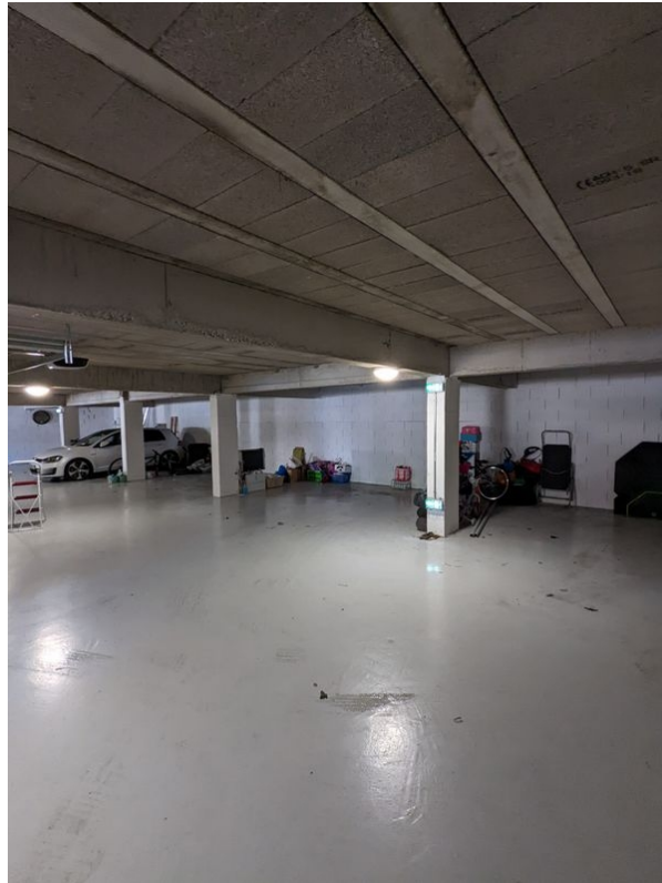
Stockage dans parc de stationnement
