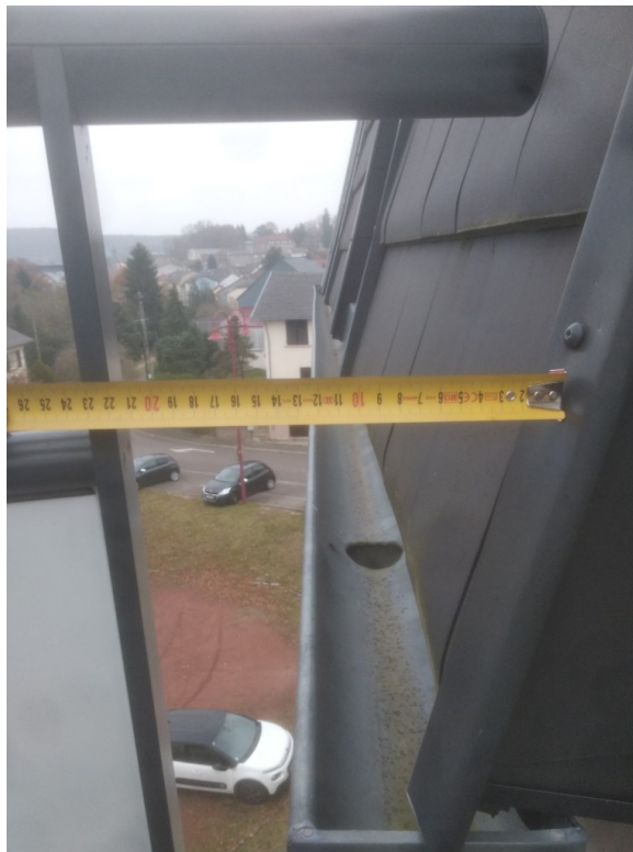
Exemple de passage possible pour les jeunes enfants ( \geq 11 cm) et risque de chute
