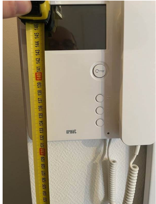
Hauteur poignée ou interphone de hauteur > 1,30m
