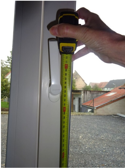
Hauteur poignée ou interphone de hauteur > 1,30m
