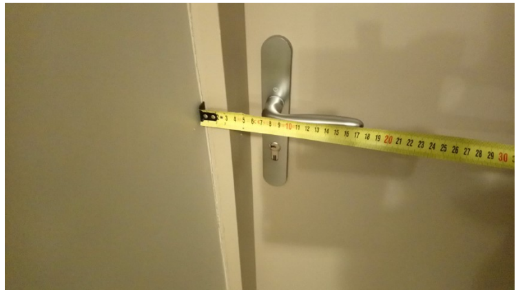
Bouton ouvre-porte d'immeuble à moins de 40 cm d'un angle rentrant Extrémité de poignée de porte palière à moins de 40 cm d'un angle rentrant (serrure à moins de 30 cm d'un angle rentrant)
