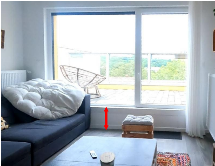
Ecart de niveau de 40 cm côté intérieur Ressaut >2cm côté extérieur entre terrasse et logement
