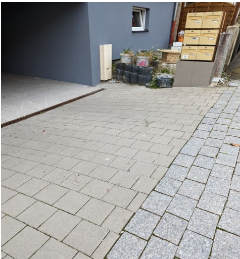
Cheminement extérieur avec forte pente (accès à l'entrée / aux boîtes aux lettres) Entrée principale d'un bâtiment avec ressaut important
