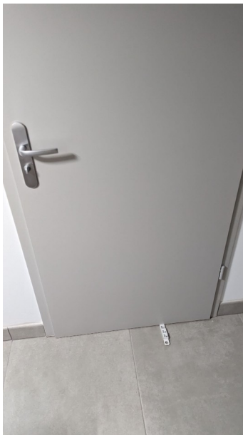
Détalonnage insuffisant de porte intérieure ~ 5mm
