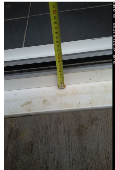
Ecart de niveau de 40 cm côté intérieur Ressaut >2cm côté extérieur entre terrasse et logement
