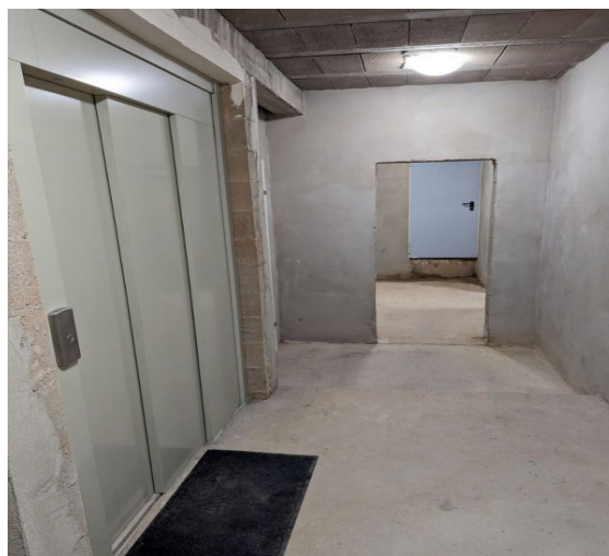
Porte ouvrant vers l'intérieur sur un ensemble de caves
