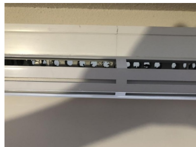
Flux d'air entrant non conforme : débit d'air requis non assuré.
