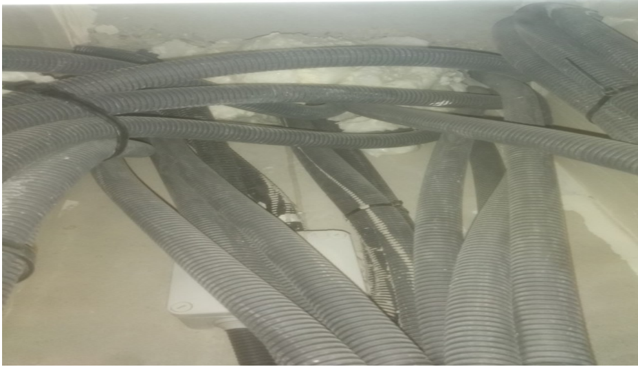
Rebouchage de passage de conduits en matériau non inflammable
