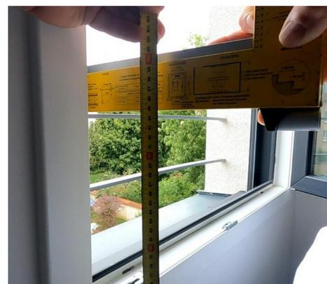
*Absence de barre d'appui et d'élément de protection sur fenêtre basse ou présence de ces éléments de protection mais ne s'élevant que jusqu'à 0,95m.*
