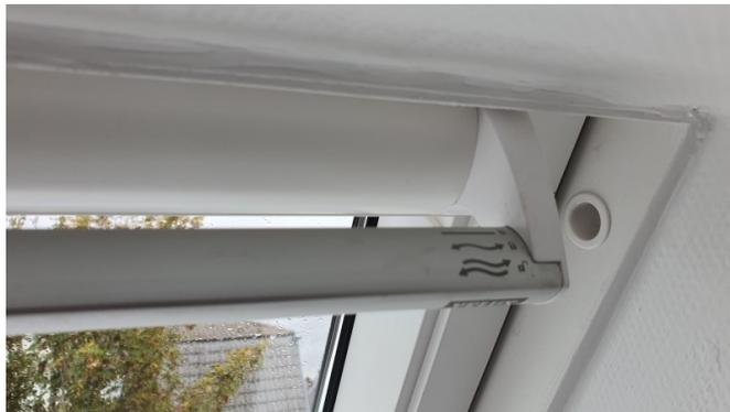
*Fenêtre de toit sur pièce principale sans entrée d'air permanente*
