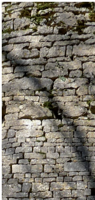
Fig 2.1.5 : différence d'appareillage sur la Grande loge : en haut, construction contemporaine de J.H. Mutel - en bas, mur monté par les élèves tailleurs
