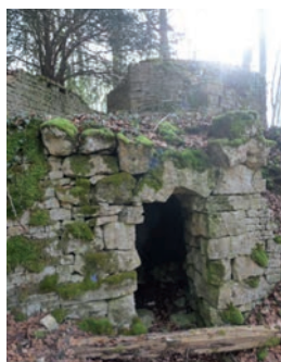
Fig 3.1.1 : les Vignes - vues de constructions en pierre sèche
