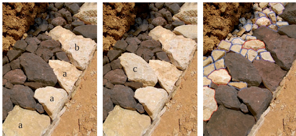
Etape 2 : mise en place des demoiselles (a), des boutisses (b) et des contre-boutisses (c)
