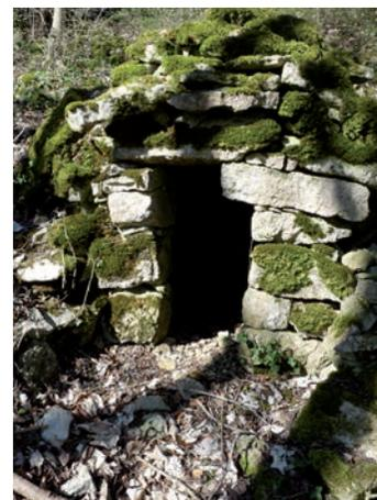
Fig 3.4.f.8 : vues des dégâts constatés sur la cadole N°4
