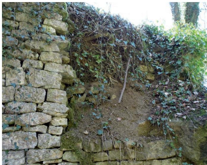
Un autre dégât constaté est dû à la combinaison du manque d'entretien et de la pierre utilisée. En effet, toutes les constructions ont été édifiées avec la pierre locale, du calcaire, qui à bien des endroits a souffert de l'érosion naturelle. Les pierres se désagrègent lentement et finissent par se déchausser en mettant en péril le reste de la muraille. Des interventions plus fréquentes auraient permis de remplacer les pierres endommagées au fur et à mesure.
