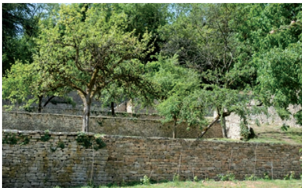
Fig III.C.3.a.1 : vues de différentes terrasses - la terrasse des vignes, la terrasse des pruniers blancs et la terrasse N°5 (en bas à gauche)
