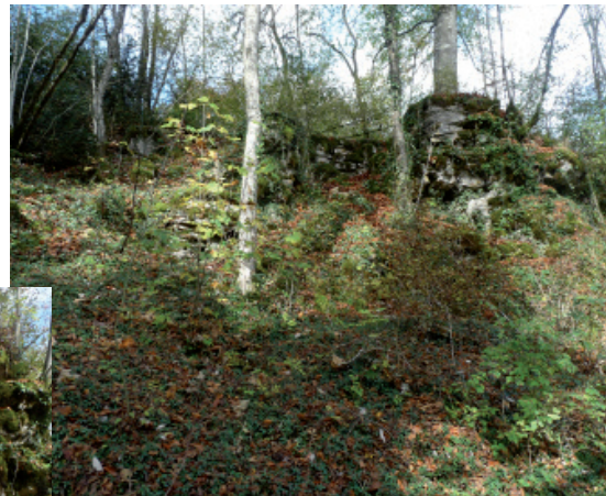
Fig IV.D.1 : vues de l'escalier dans la falaise
