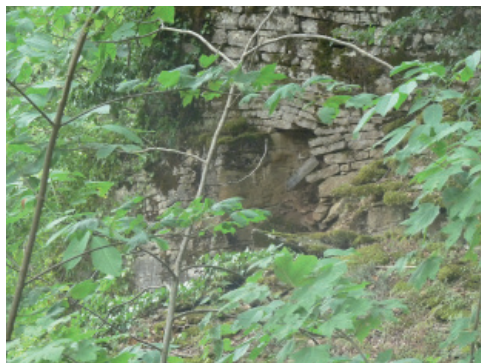
Fig III.C.3.b.3 : vue des dégâts sur la toitures en laves
