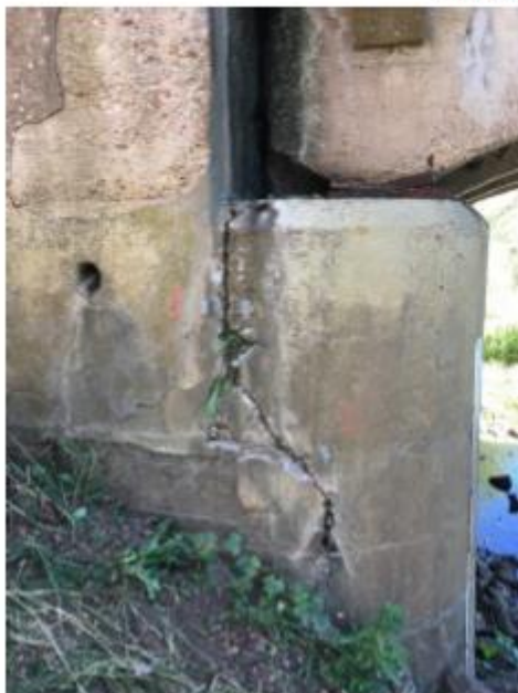
Fracture de la culée C3 (aval)
