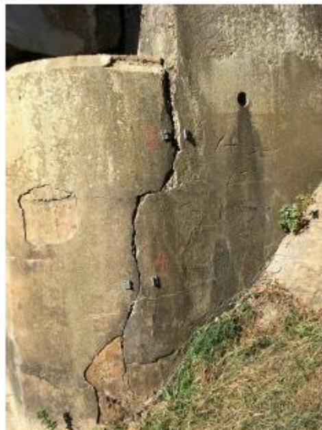
Fracture de la culée C3 (amont)
