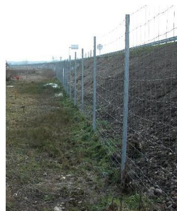
Les clôtures utilisées sur cette route correspondent en majorité à un type largement utilisé dans le domaine autoroutier et sur les routes du réseau de la DIRE. Il s'agit d'une clôture soudée à maille progressive de type 3 ou 250-20-15 (comme illustré ci-contre), utilisée principalement pour stopper la grande faune (Cerema 2019a), et dont les caractéristiques principales sont les suivantes :
