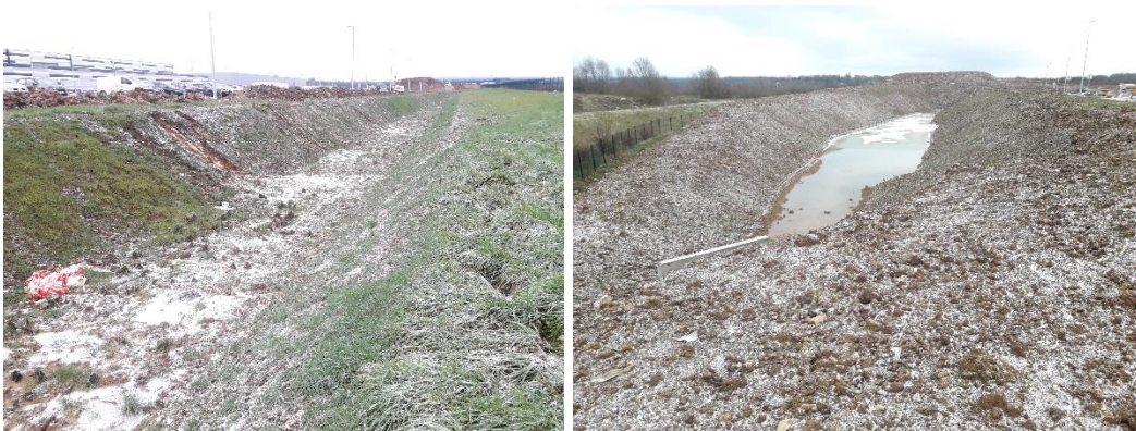
Photo 5 : Bassins d'infiltration présents sur le site, ECOLOR 2023
