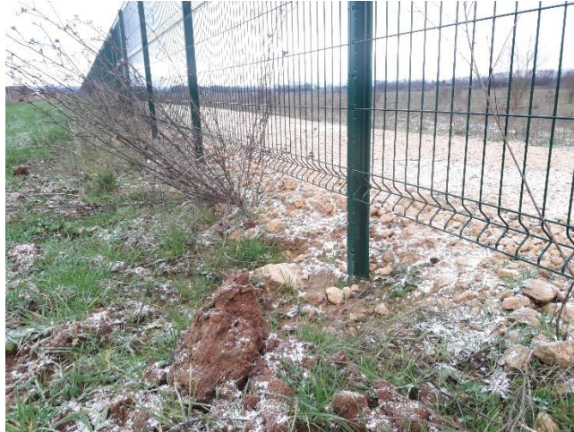
Photo 2 : Grille perméable à la petite faune - photo prise sur site, ECOLOR 2023
