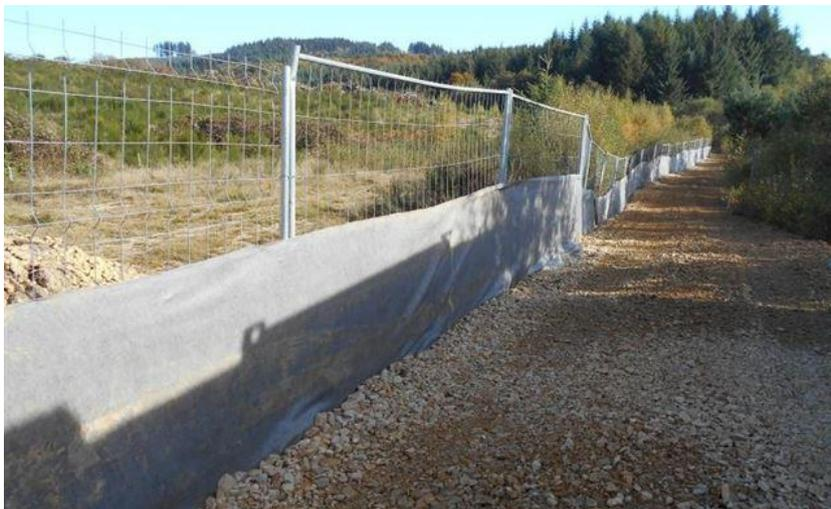
Figure 19 : Exemple de clôtures bâchées
