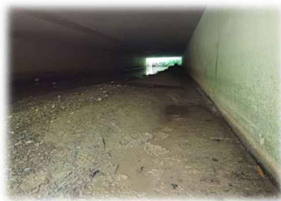
Figure 55 : ouvrage de franchissement du Spechbach par l'A36. Burnhaupt-le-Bas, juillet 2024.
