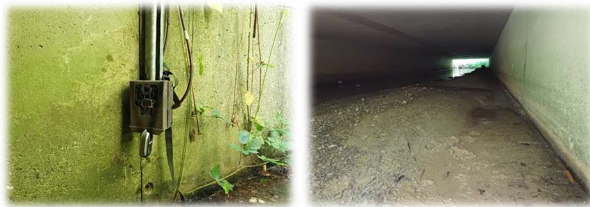
Figure 19 : vue du piège photographique mis en place et de la zone filmée correspondant à l'ouvrage de franchissement du Spechbach par l'A36. Burnhaupt-le-Bas, juillet 2024.
