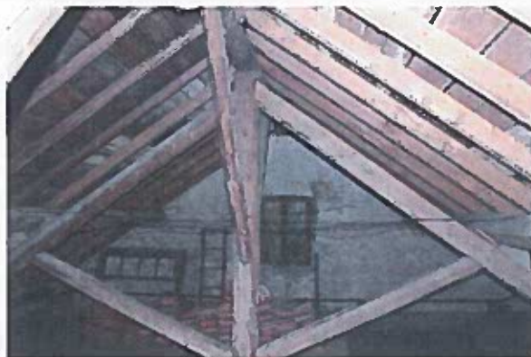
Figure 11 : vue des combles du bâtiment de l'annexe de l'Hôtel du Tétrás. Le Valtin, octobre 2016.
