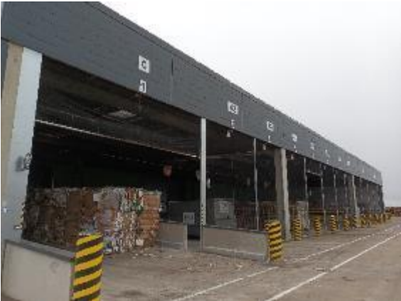
Quai bennes vue extérieure
