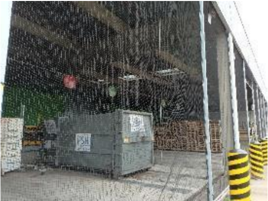
Filet quai benne vue extérieure
