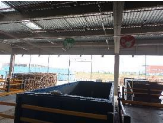
Filet quai bennes vue intérieure
