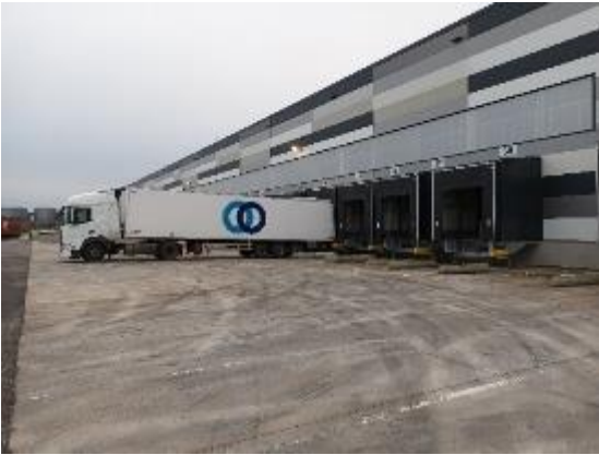
Mise à quai de poids lourds vue extérieure
