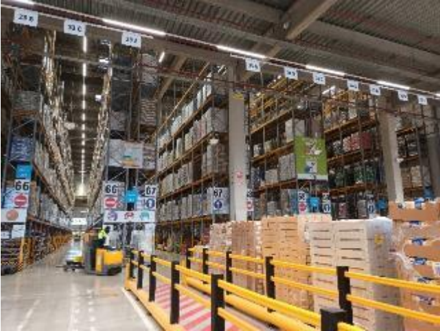
Cellule 3 « sec » de préparation de commande
