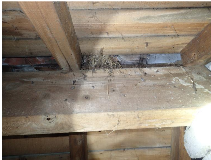
Nid de Moineaux domestique sur la poutre faîtière du comble
