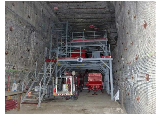
Installation en voie JR pour réception du béton au fond
