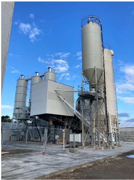
Fabrication du béton au jour, acheminé au fond par le puits Else via une conduite
