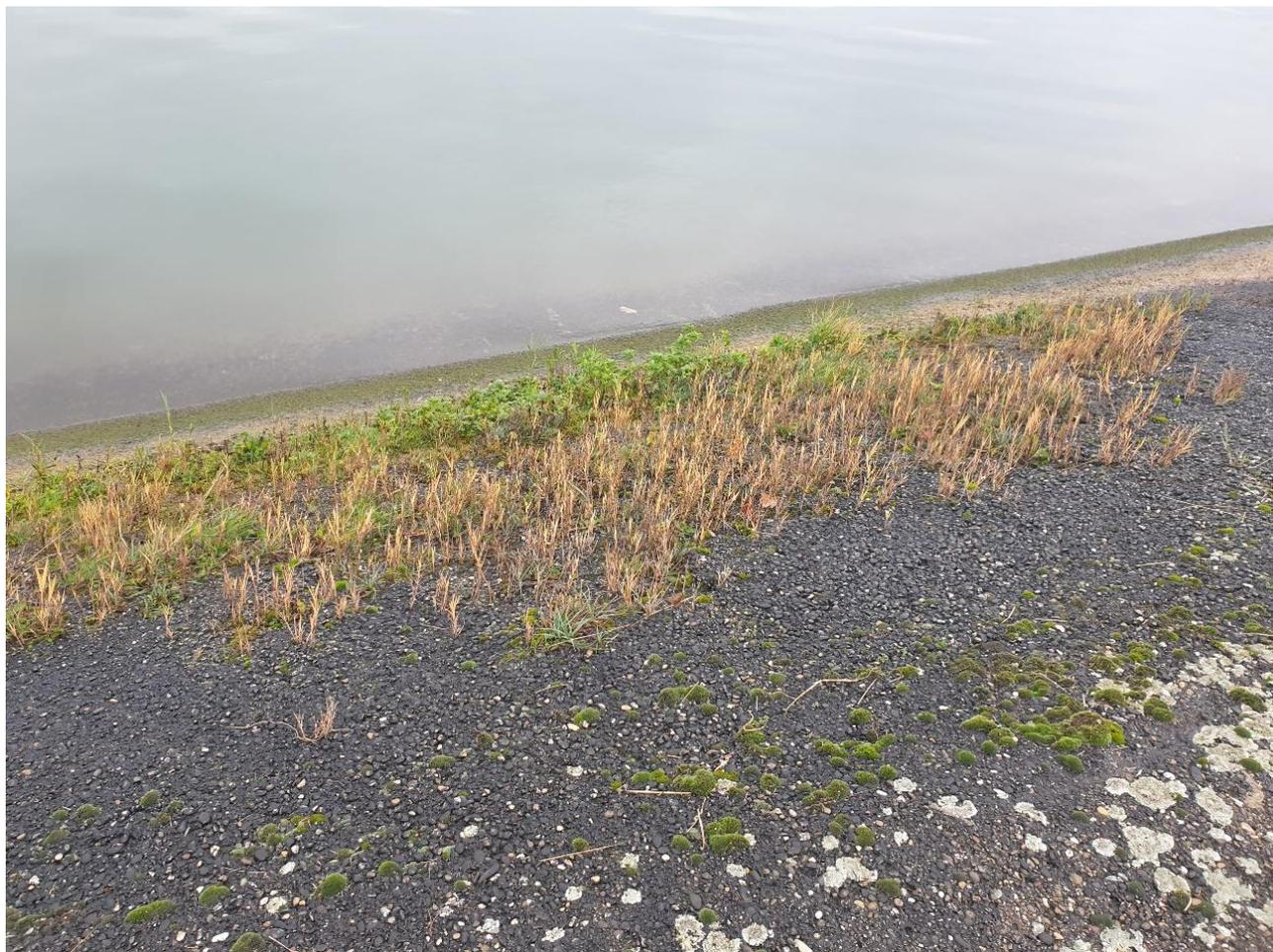
Figure 10 – Affaissement du parement
