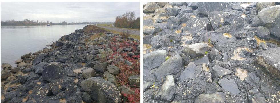
Figure 19 – Parement en enrochements percolés
