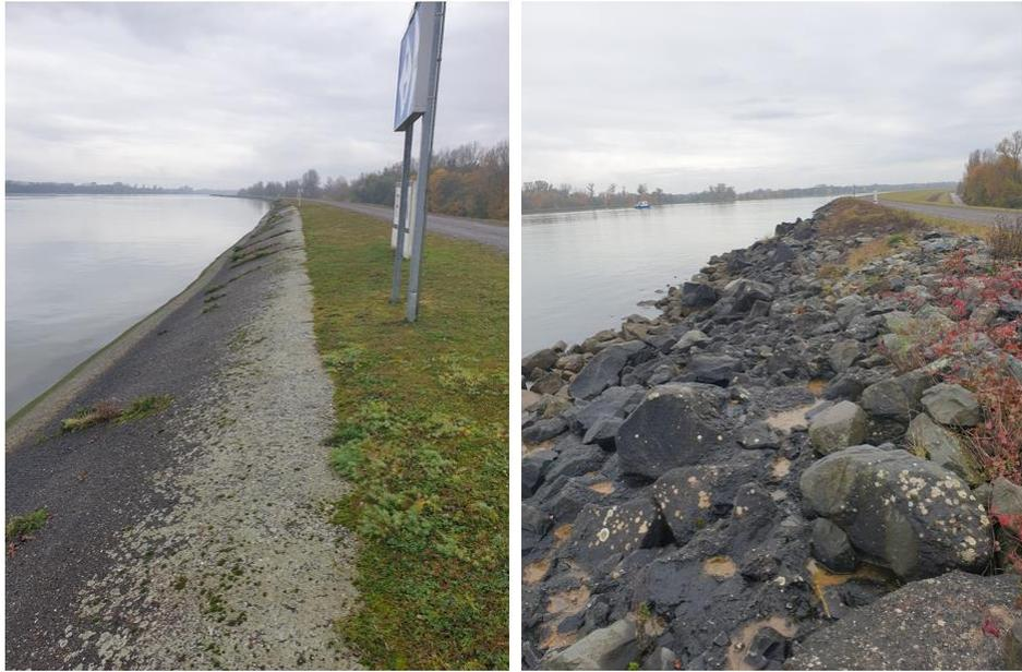
Figure 2 – Parement côté Rhin avant travaux de confortement en gabion (parement en béton bitumineux/parement en enrochements percoulés)
