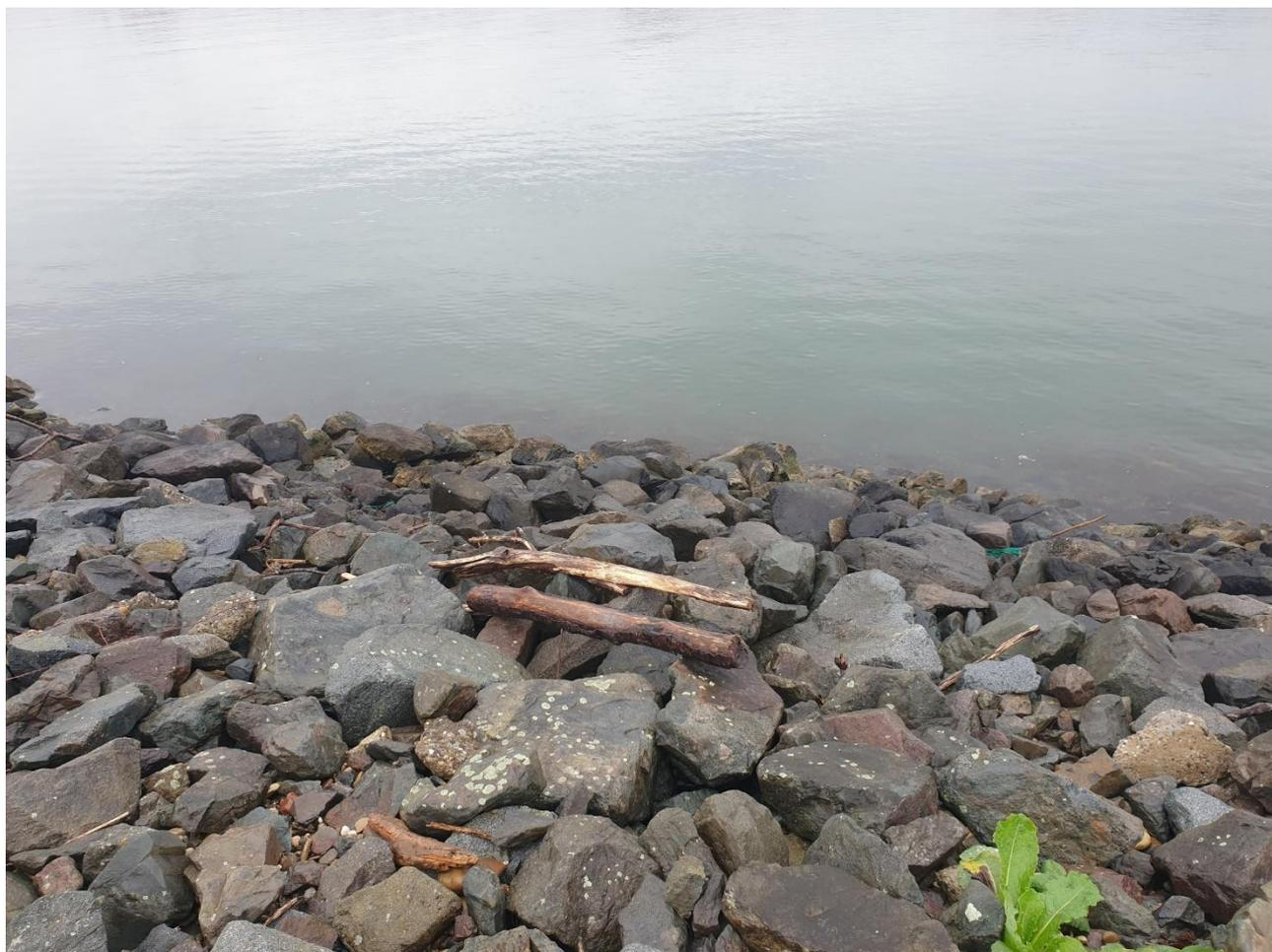
Figure 23 – Parement en enrochements
