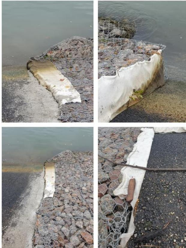
Figure 17 – Liaison matelas gabion et parement initial
