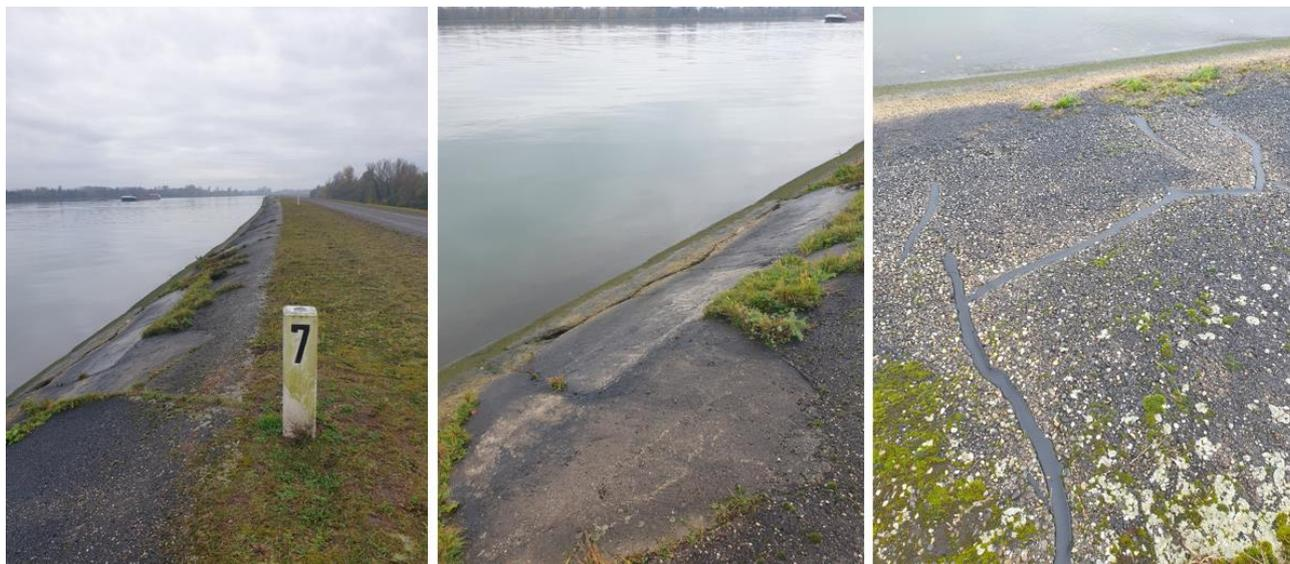
Figure 6 – Parement particulièrement dégradé
