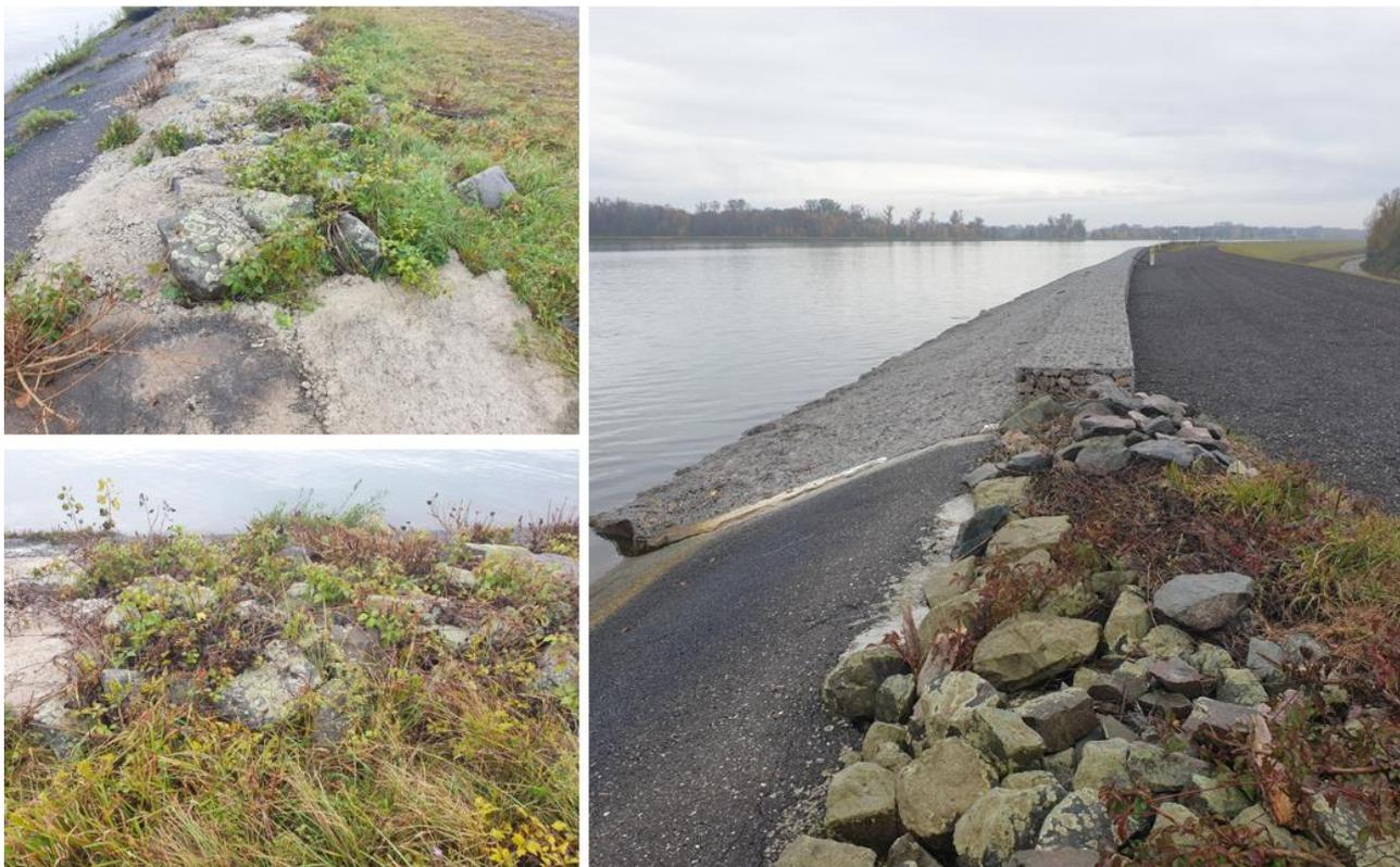
Figure 14 – Surélévation de la crête par des enrochements
