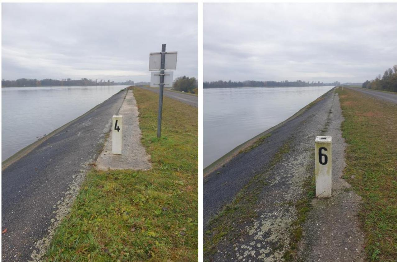
Figure 8 – Crête végétalisée/bétonnée sur 60cm
