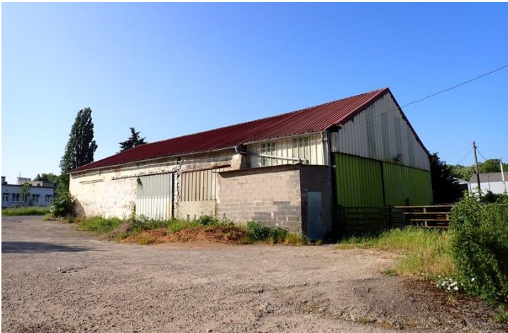
Bâtiment agricole en mai 2023
