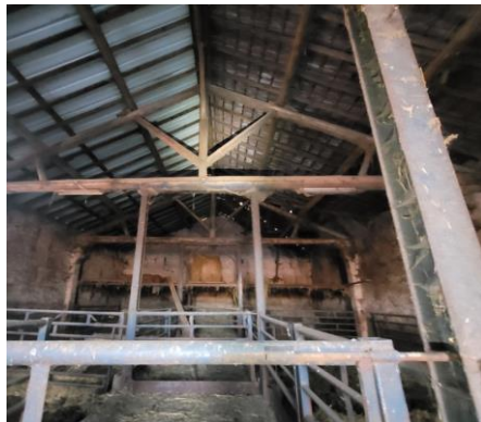
Intérieur du bâtiment agricole
