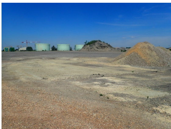
Zone gravillonnée secteur Est
