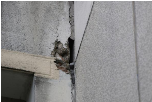
Ci-contre, exemple d'anfractuosité présente en façade n°4 du bâtiment A – mercredi 21 mai 2025 – Reims (51) ©J. MIROIR-ME 2025
