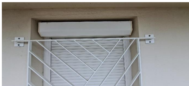
Ci-contre, vue de détail par-dessous d'un caisson de volet roulant permettant de voir ses caractéristiques structurelles et sa configuration extérieure – mercredi 21 mai 2025 – Reims (51) ©J. MIROIR-ME 2025
