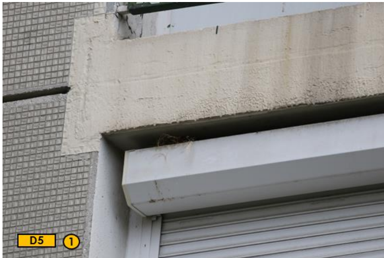
Ci-contre, vue d'un nid de Moineau domestique établi au-dessus d'un caisson de volet roulant - observé en façade n°5 du bâtiment D au 3 ème étage - 21 mai 2025 - Source : ©J. MIROIR-ME 2025.
