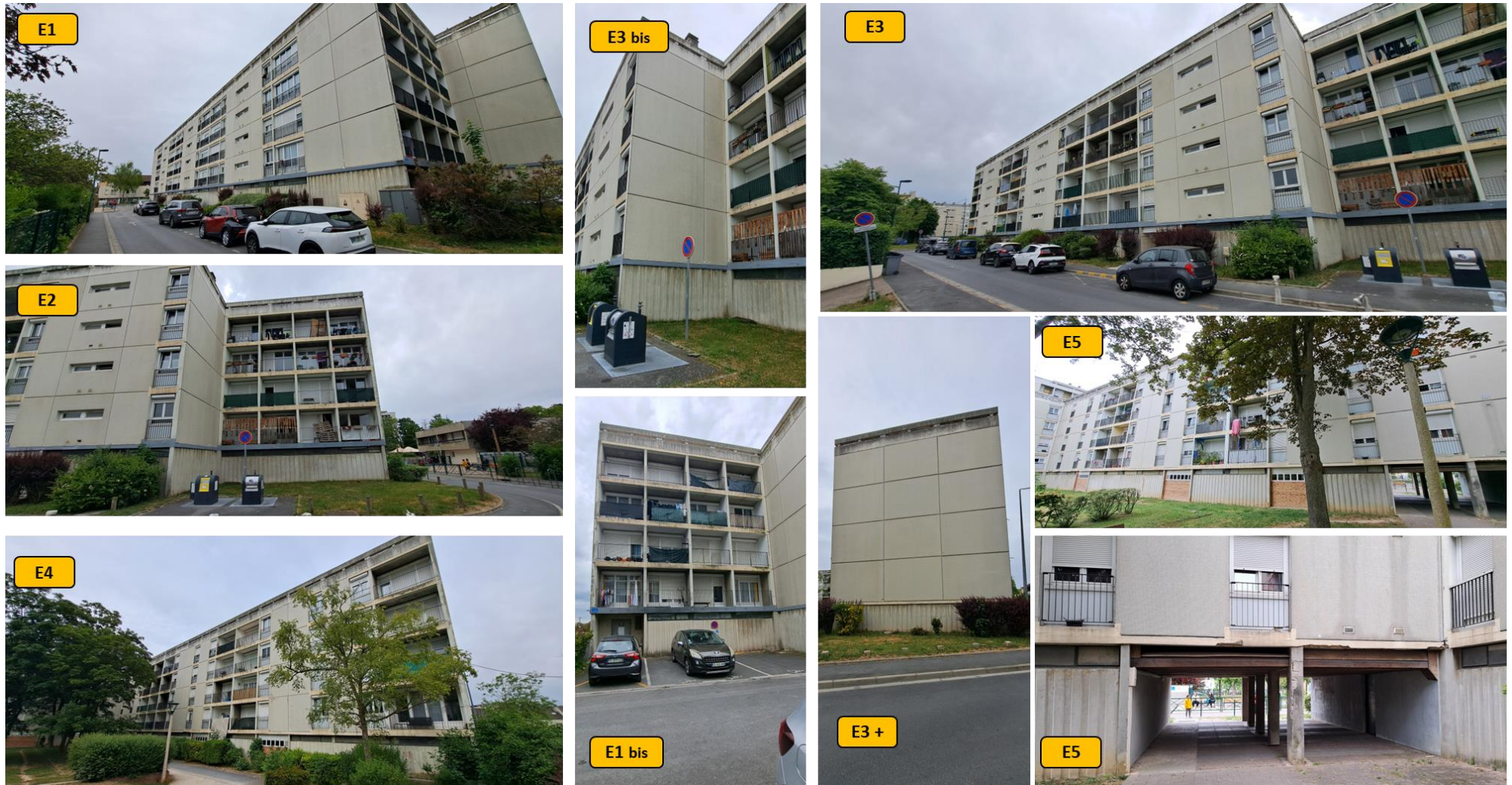
Ci-dessus, vues de façades du bâtiment E – planche 1/2 - 10 juillet 2025 - Source : ©J. MIROIR-ME 2025.
