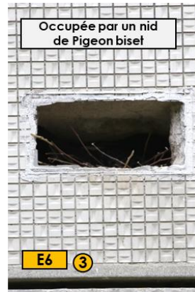
Ci-contre, vues de bouches d'aération dépourvues de grilles extérieures - observée en façade n°6 du bâtiment E - 21 mai 2025 - Source : ©J. MIROIR-ME 2025
