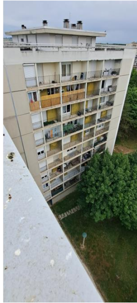
Ci-contre, à gauche, vue de la façade n°3 du bâtiment A et à droite, vue de la façade n°7 du bâtiment D – prise de vue à partir des toits – mercredi 21 mai 2025 – Reims (51) ©J. MIROIR-ME 2025
