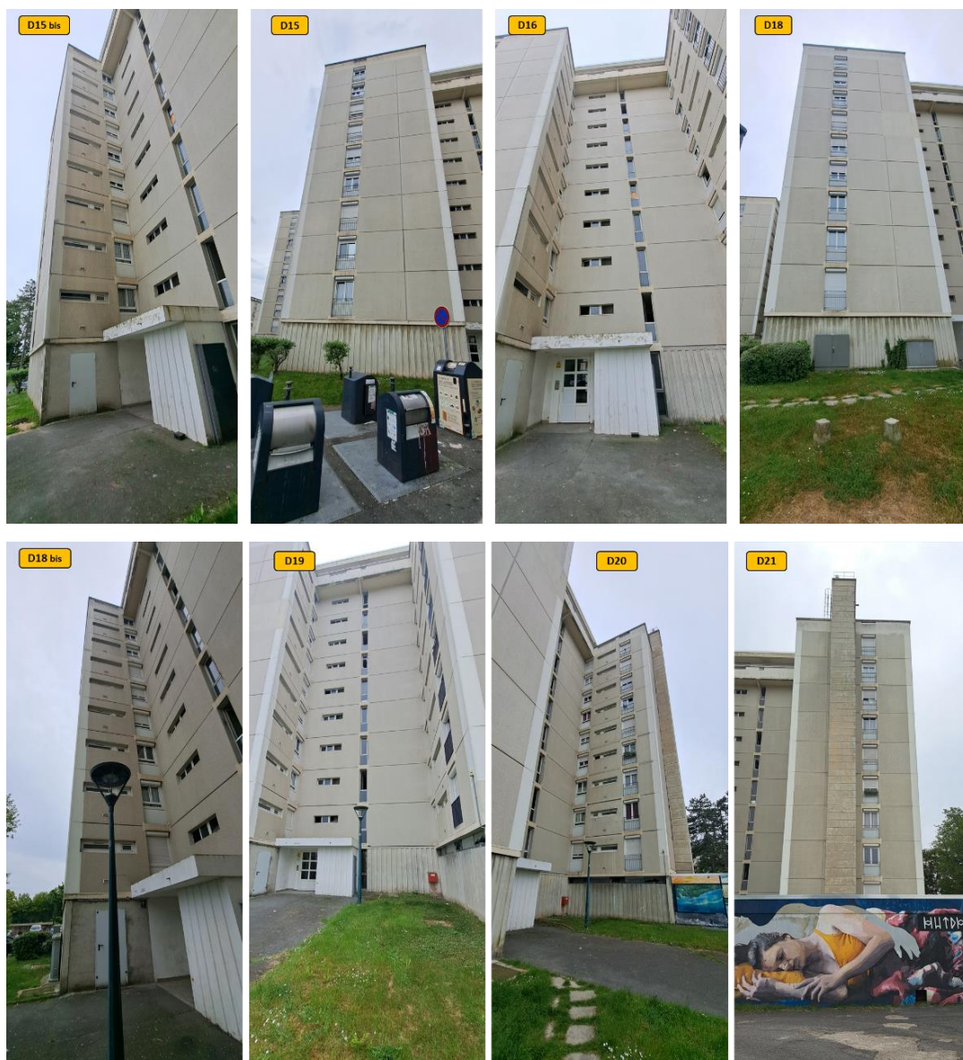
Ci-dessus, vues de façades du bâtiment D – planche 3/3 - 10 juillet 2025 - Source : ©J. MIROIR-ME 2025.
