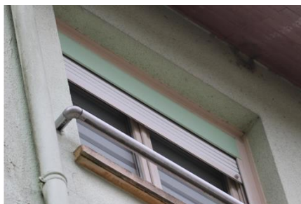
Ci-contre, vues de détail de composantes des bâtiments généralement exploitées par la faune : à gauche sous toiture et à droite, caisson de volet roulant et angles de fenêtres – jeudi 6 mai 2024 – Ligny-en-Barrois (55) ©J. MIROIR-ME 2023
