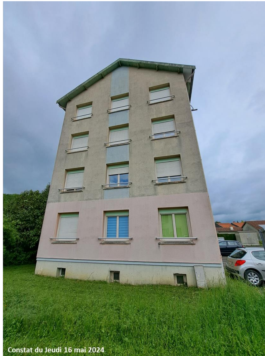
Ci-contre, vue de la face Sud de la résidence n°2 – 16 mai 2024 – Ligny-en-Barrois (55) ©J. MIROIR-ME 2024
