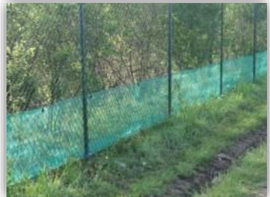
Photo 44 : barrière anti-amphibien directement attachée sur la clôture (Téting-sur-Nied, Ecolor 2017)
