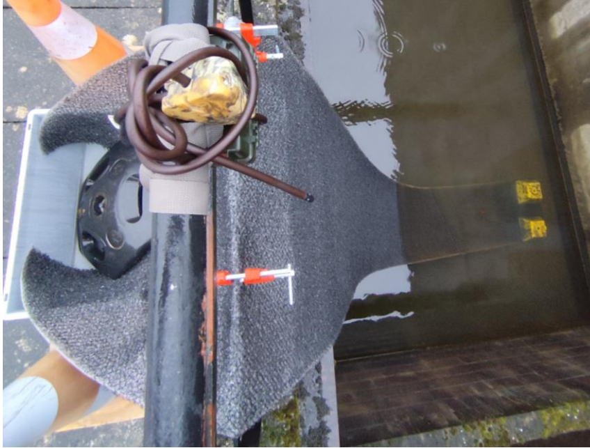
Figure 2 : Exemple d'une échappatoire installé sur dans un bassin d'orage sur le site de Dirinon (Finistère)
