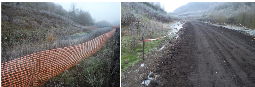
Exemples de balisage perméable temporaire sur un chantier (Source : AdT)
