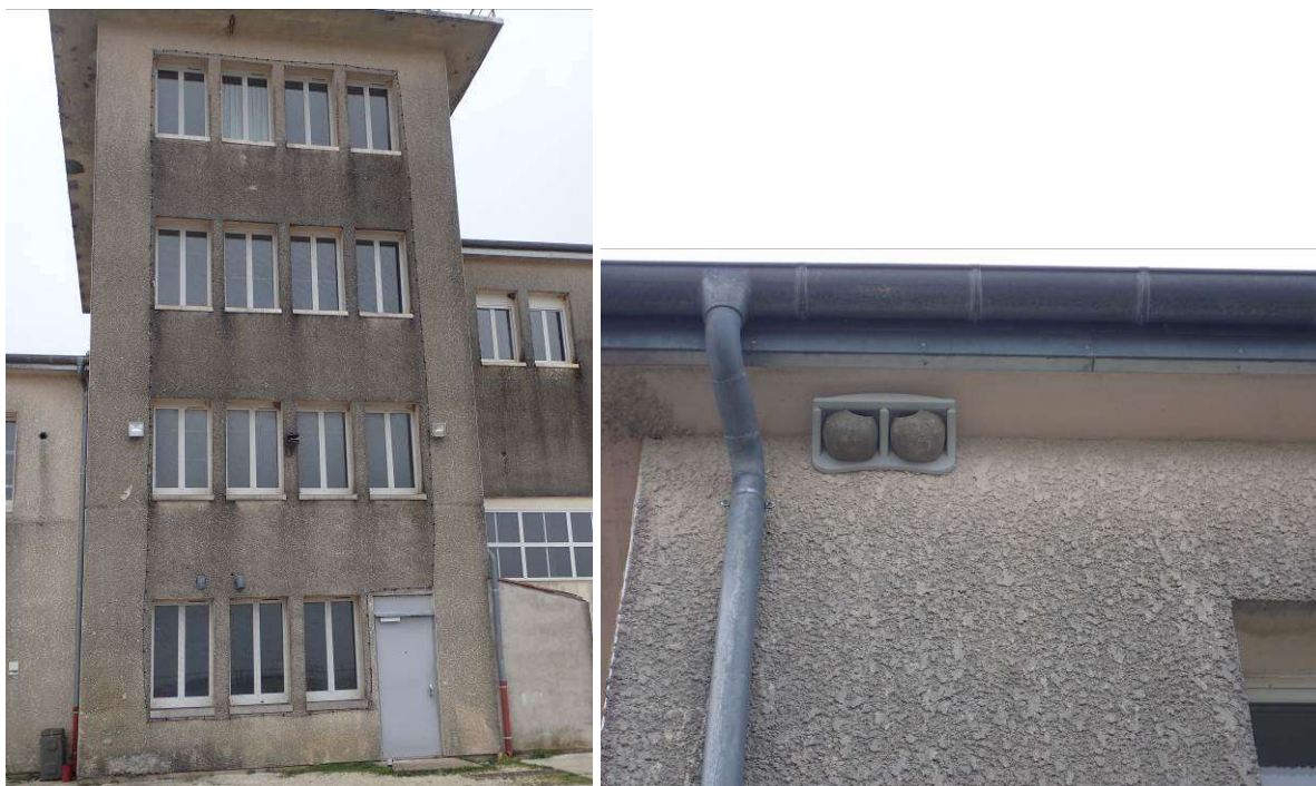
Filets installés sur les fenêtres de la tour et nichoirs posés sur les ailes du bâtiment
