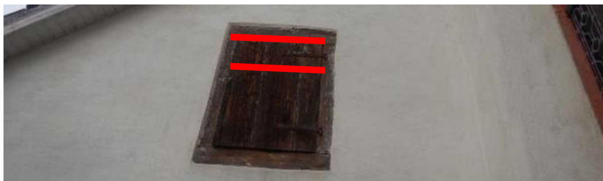
Création d'un accès pour les chauves-souris vers la sacristie : fente d'accès de 2-6cm de hauteur en haut ou en partie centrale de la porte
