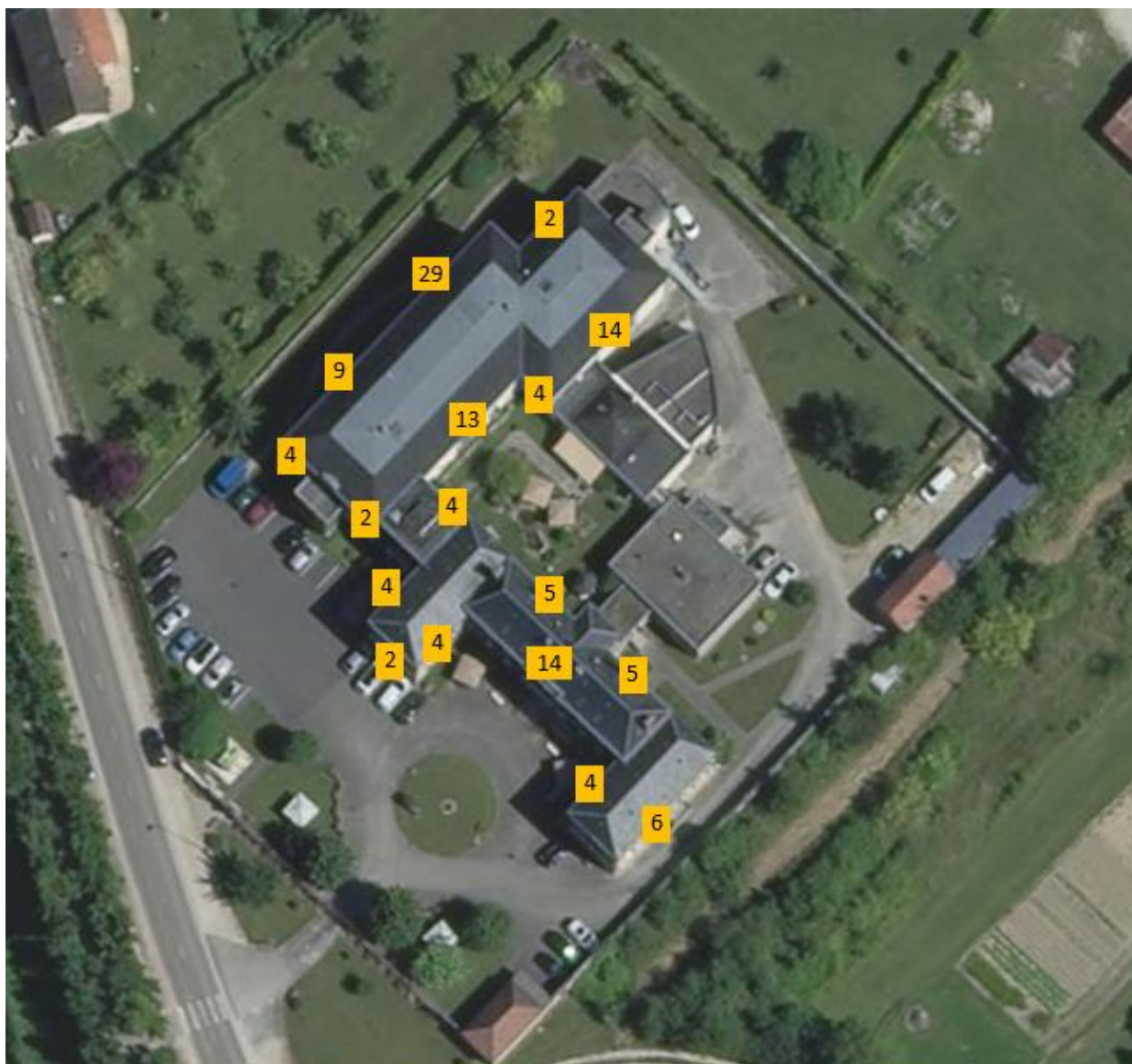
Figure 4 : Nombre de nids sur les différentes façades de la résidence
