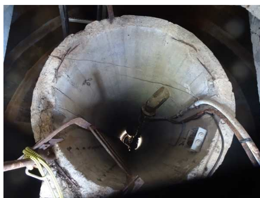
Tourelle béton permettant l'accès au réservoir
