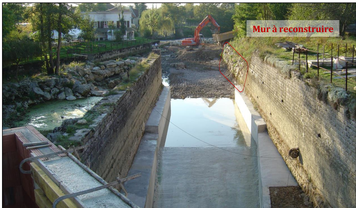
Figure 5 : Vue vers le canal de fuite lors des travaux de 2004 avec les murs existants et le mur temporaire en enrochements à reconstruire (source : MHEC, automne 2004).
