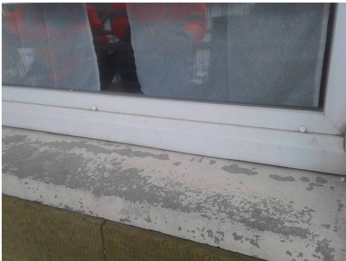
FIGURE 5 : HUISSERIE AVANT TRAVAUX DE RENOVATION
