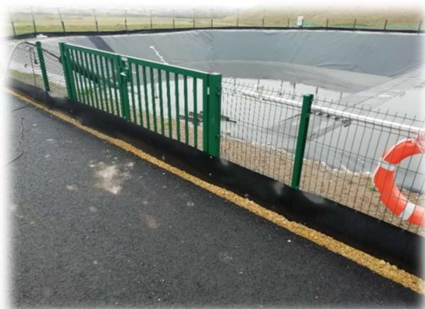
L'avantage de cette technique est que les engins de chantier sont suffisamment éloignés de la clôture pour ne pas abîmer le filet donc il y a moins de risque d'arrachage, la prise au vent reste limitée avec le filet, et la pose est plus facile pour les agents.
