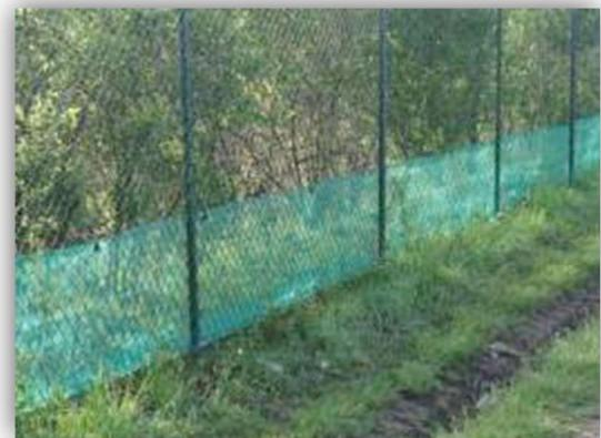
**Photo 52 : barrière anti-amphibien directement attachée sur la clôture type filet et bâche rigide (Téting-sur-Nied, Ecolor 2017 2021)**
