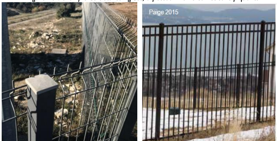
Figure 19 : exemple de clôtures rigides, à poteaux non creux et sans piquants
