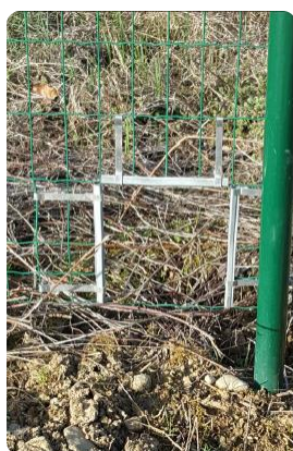
Surélévation du grillage de 10 à 20 cm
