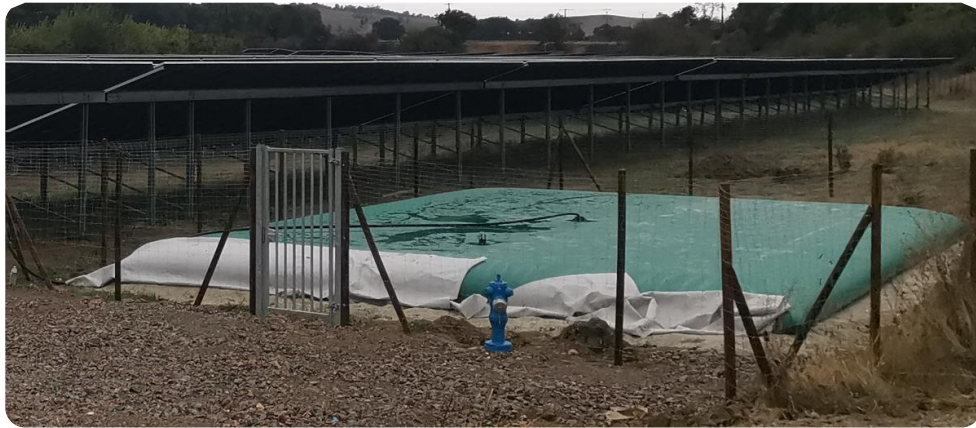
Figure 16 : Mise en place d'une citerne souple. Source : Enoé.
