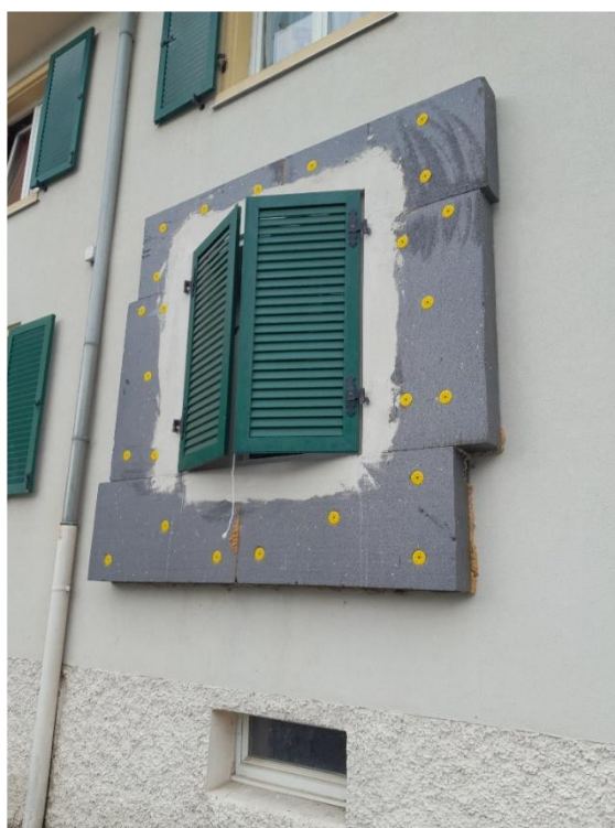
Figure 1 : exemple de mise en place des isolants à Châtenois, © L. BURTHEY, Biotope, 2025 Cette image est un pilote présentant la façade après travaux, les travaux n'ont pas encore commencé sur l'aire d'étude rapprochée
