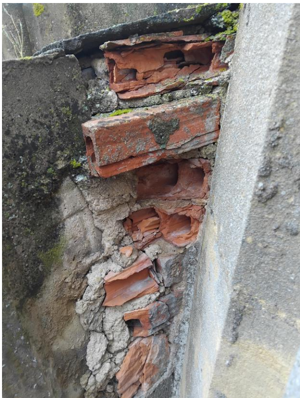
Glacis tombé et risque de chute des éléments non protégés
