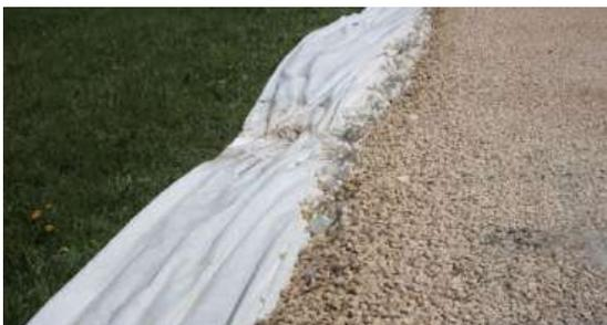
Ci-contre, exemple de desserte aménagée dans le cadre de la reconstruction de la ligne LSV- Portée du pylône n°26 au n°27. On notera que la nappe de géotextile dépasse largement de part et d'autre de la piste. Le mercredi 29 avril 2015 – Source : © J.MIROIR-ME
