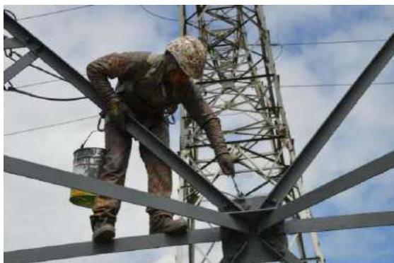
Cette opération induit 3 passages sur le pylône : Après acceptation de la qualité de la préparation de surface, il y a application de la première couche anti-corrosion et après un temps de séchage, il y a application de la couche de finition.
