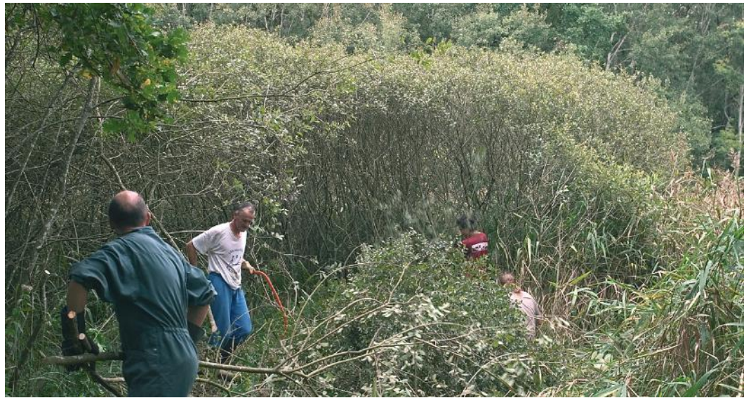
Photo 14. Travaux de restauration du milieu (Cariçaie) réalisés à l'automne 2004.
