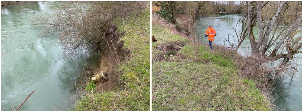
*Figure 11 : Erosion de berge à Blaincourt-sur-Aube*
