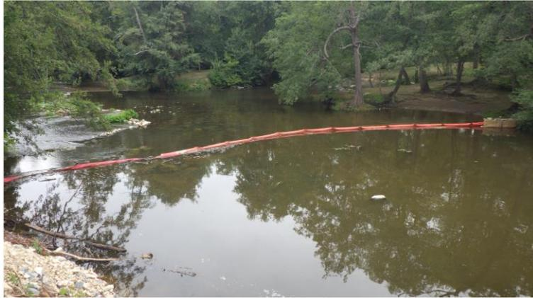
Figure 38 : Exemple de barrage anti-MES flottant
