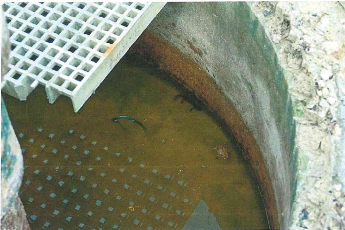
Figure 24 : Exemple de piège pour la batrachofaune, ici une buse ouverte (photo prise hors site).
