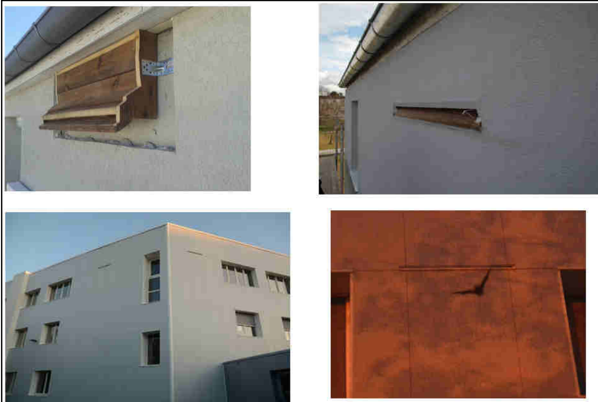
FIGURE 18 : MISE EN PLACE DE CAISSONS SUSPENDUS
