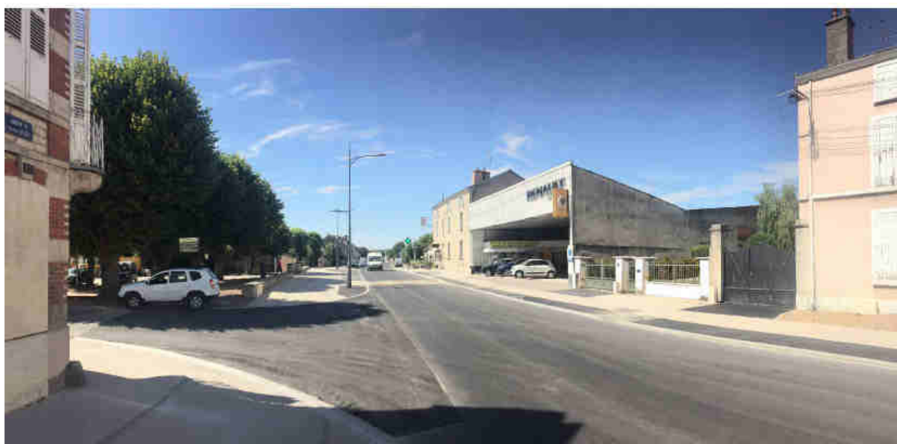
Vue du bâtiment existant dans le paysage proche
