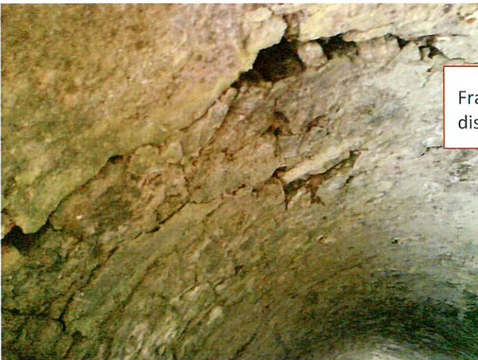
Fracture au niveau de la clef de voûte, disjoints et perte des pierres de la douelle.
