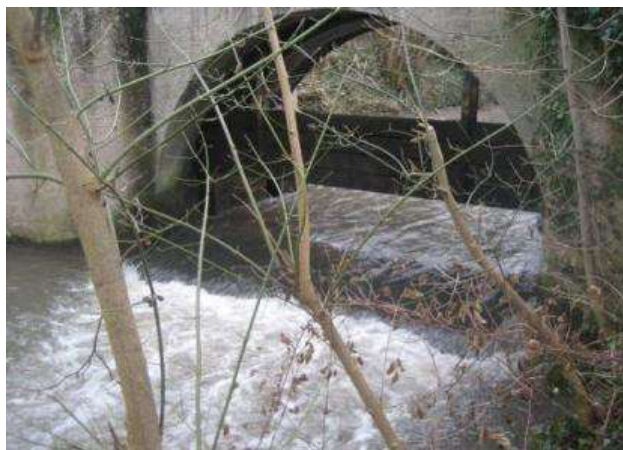
Figure 8 : Ouvrage OH3 vannage levé et Muhlbach à l'amont du seuil
