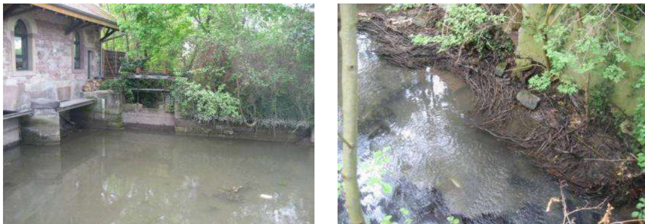
Figure 7 : Vanne de décharge en rive droite de l'ouvrage OH1 et bras de décharge
