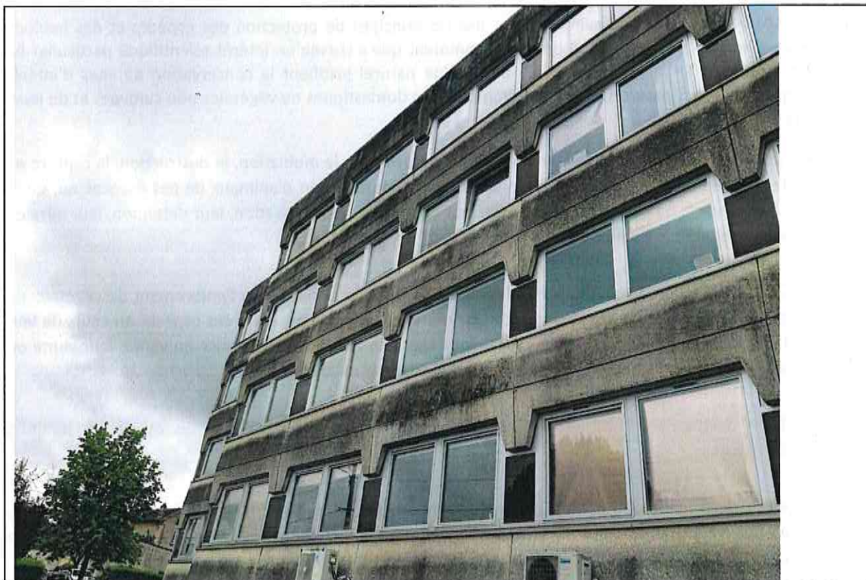
Figure 1 : Le bâtiment C présente des éléments béton derrière lesquels des individus isolés de Pipistrelle commune ( Pipistrellus pipistrellus ) ont été observés
