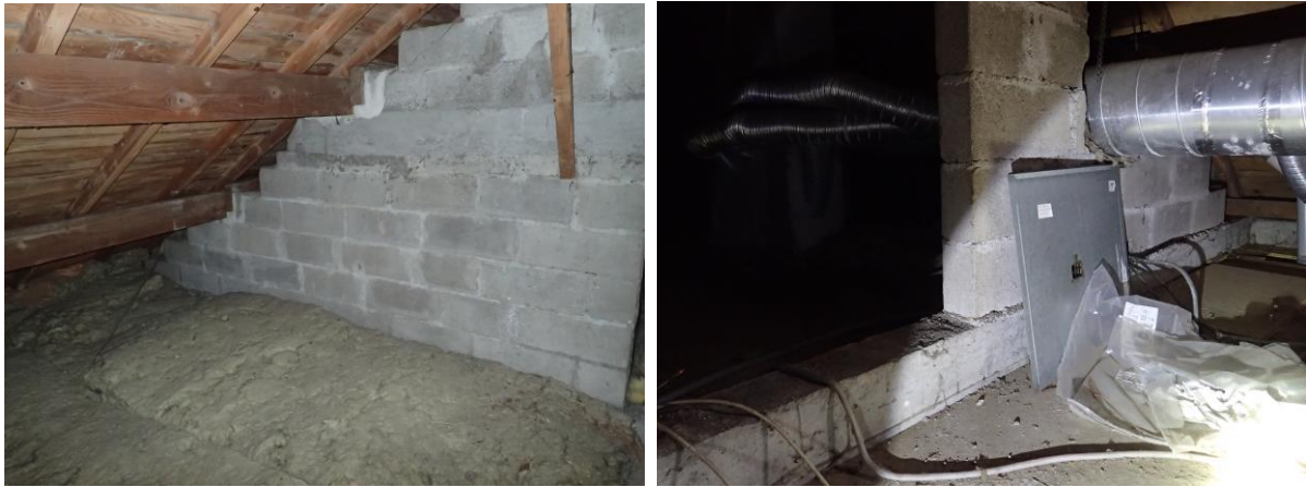
Combles de la barre d'immeuble
