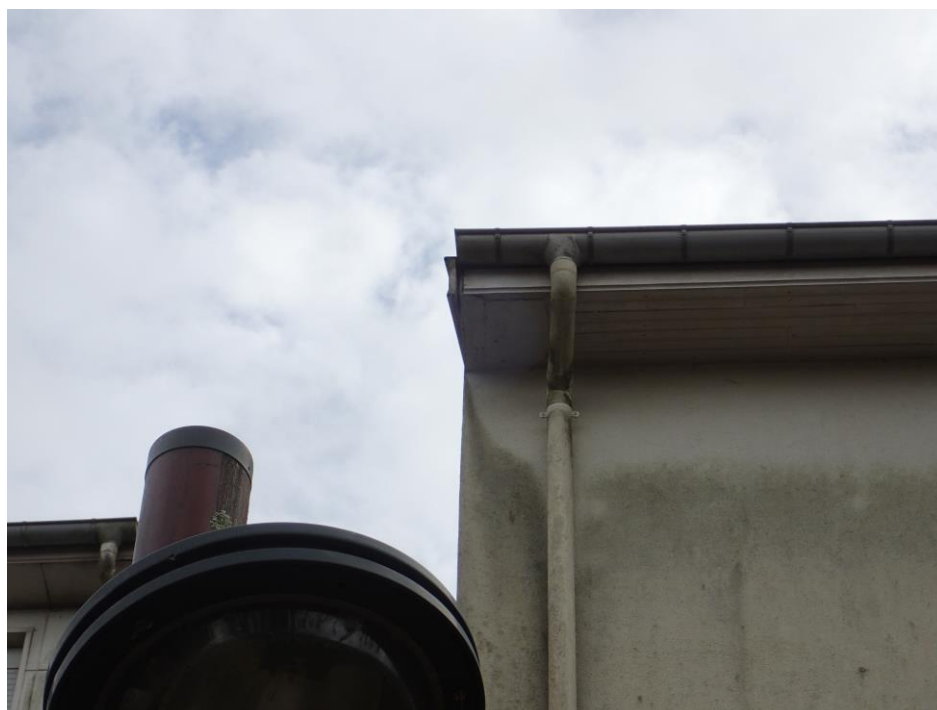
Nid de mésange bleue façade côté jardin, en débord de toit
