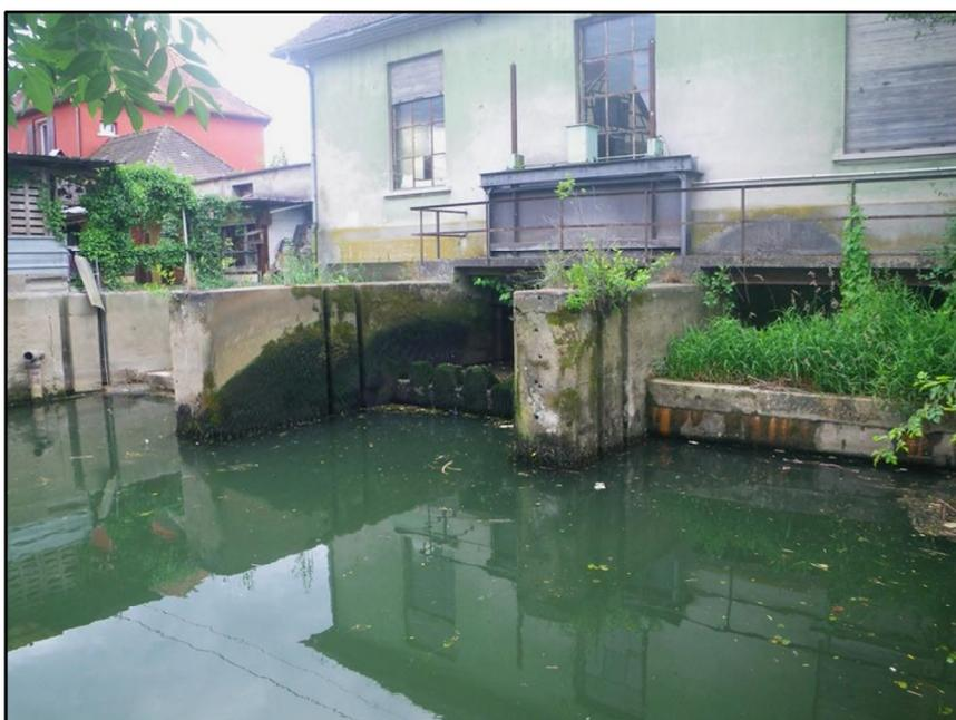
Face NE (aval) du moulin, vue de la rive gauche du canal, montrant la vanne (levée) d'isolement aval (métallique) de la chambre d'eau médiane occupée par la dernière turbine exploitée par EDF.
