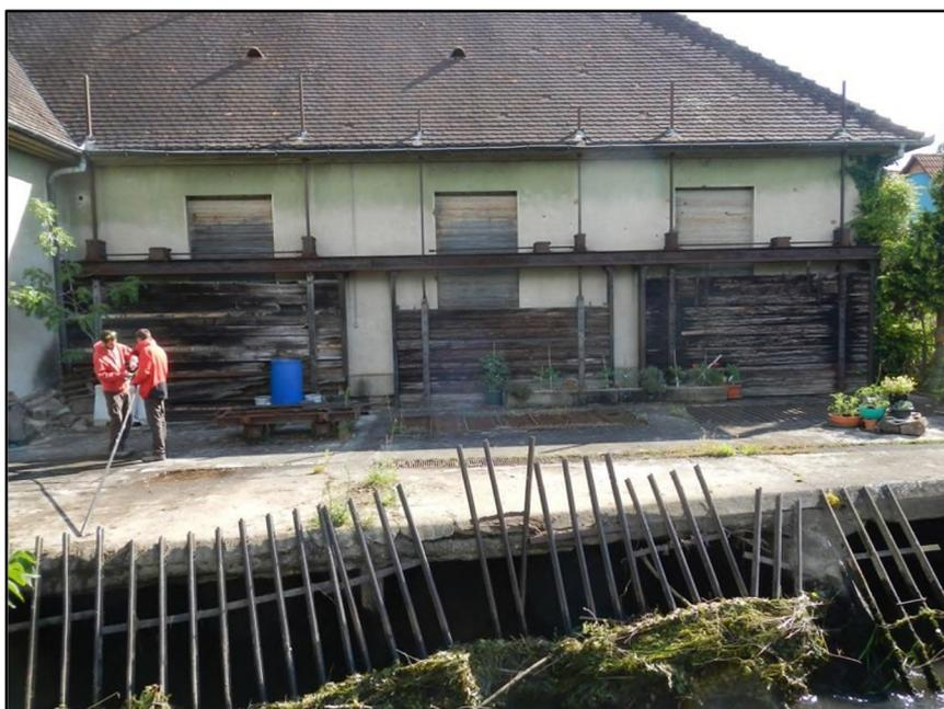
Façade SO (amont) du moulin, vue depuis le parapet du pont de la D 21, avec au premier plan les grilles protégeant les 3 chambres d'eau dont on voit en arrière les vannes d'isolement amont levées, en bois.
