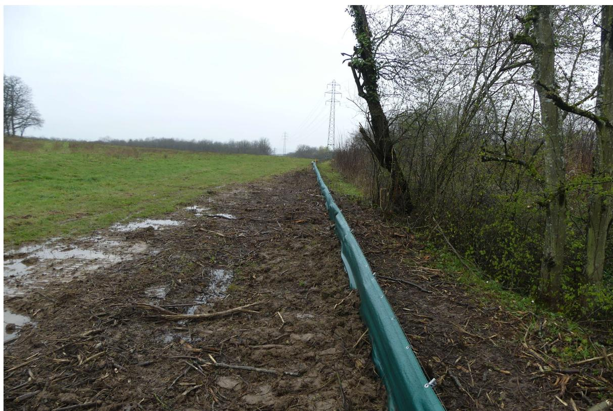
Figure 25 : Filet à amphibiens en limite nord du site (mars 2024)
