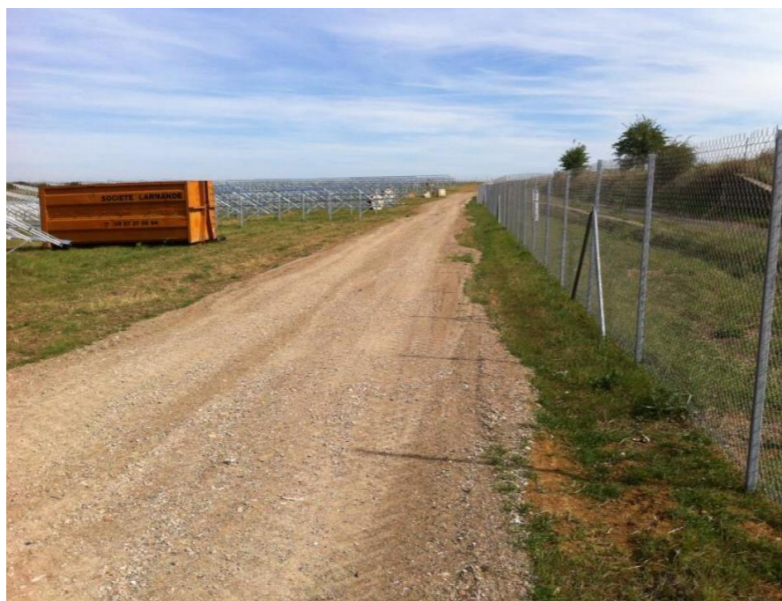
Figure 27. Exemple d'une bande de roulement adaptée aux véhicules lourds (Source : TSE).
